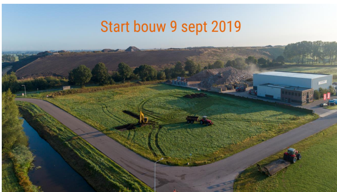
Start grondwerkzaamheden Duitslanddreef 7, Heerenveen. De locatie waar het NTCP wordt gebouwd.
